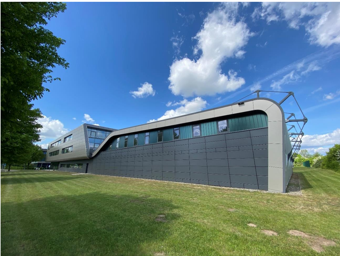
Die Südseite des Gebäudes. Im hinteren Teil ist die Produktionshalle 2 erkennbar.
